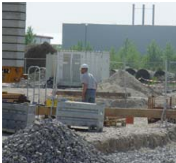
Κατασκευή διυλιστηρίου βιοκαυσίμου στο Enns
