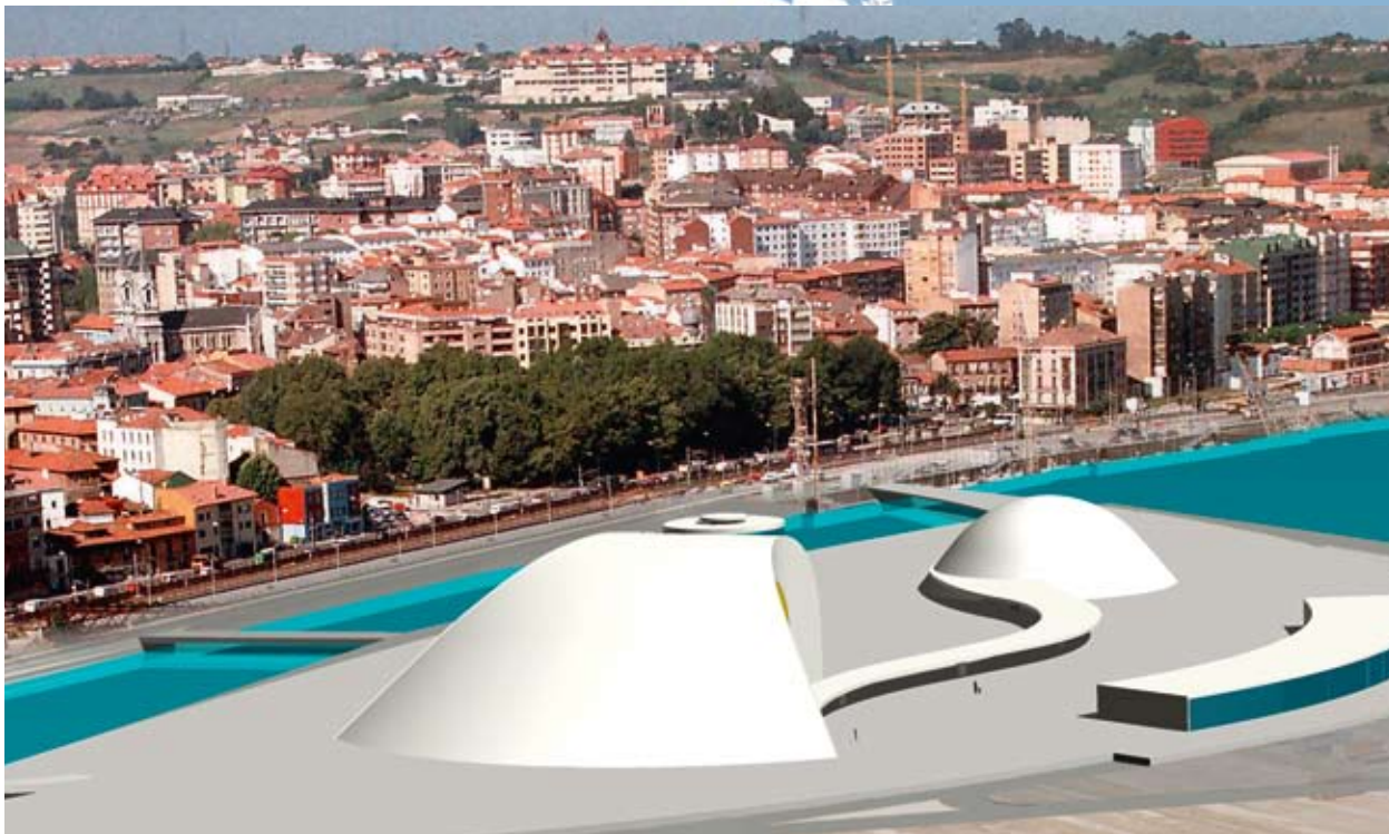
Το υπό κατασκευή Κέντρο Oscar Niemeyer θα μεταμορφώσει την Avilés
